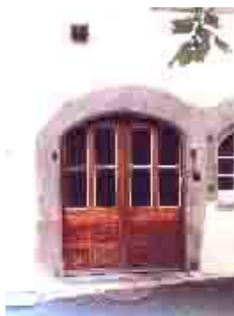
Entrée d'une ancienne maison de Rébénacq sur la place de la Bielle. (1606)
